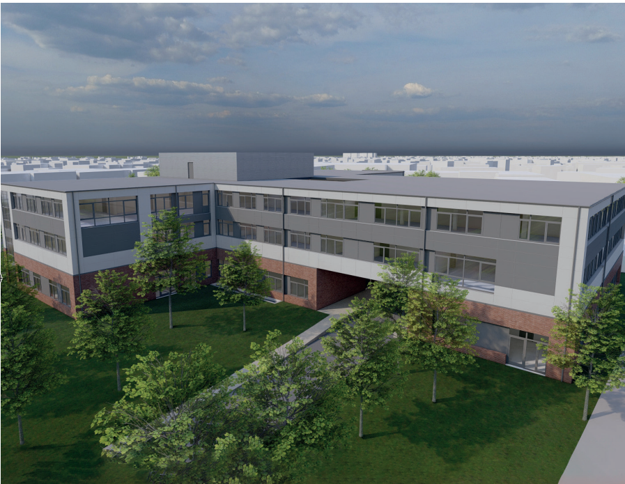
So soll die neue Psychiatrie am WKK Heide aussehen. Fertig werden soll der Neubau Ende 2026.
